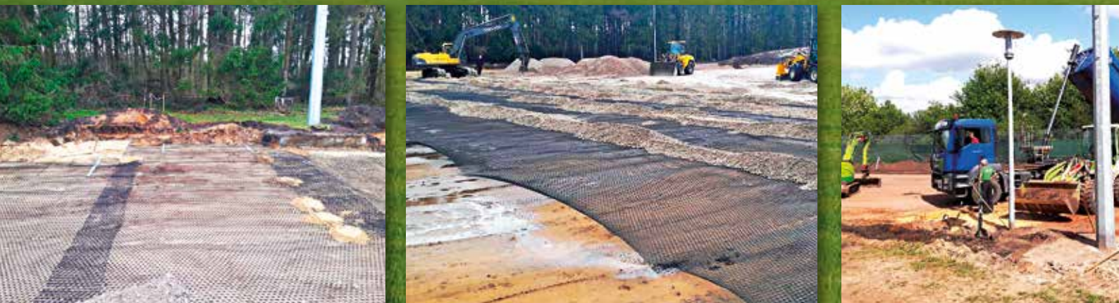
Für einen optimalen Schutz wurde das Geogitter überlappend ausgelegt und überschüttet
